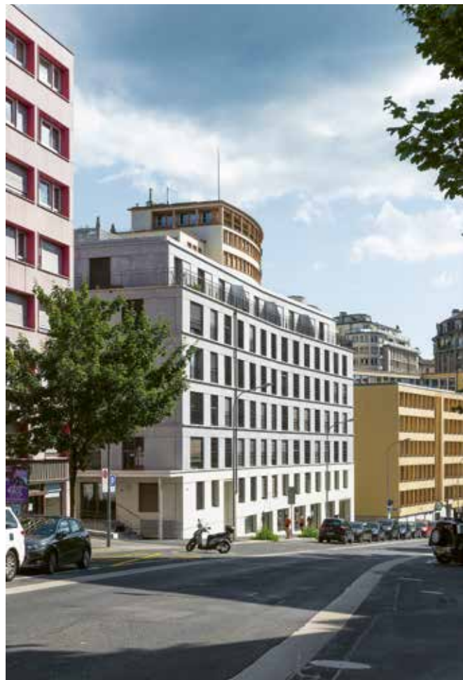
Le nouveau bâtiment de la rue Saint-Martin à Lausanne s'inscrit dans la continuité urbaine de la rue avec élégance et sobriété; il offre une adresse digne et solide à une population précarisée.
